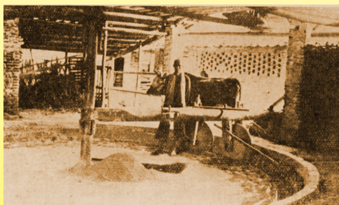
Broyage du kaolin par des meules actionnées par un bœuf (1939, Vietnam, Bulletin économique de l'Indo-Chine)
