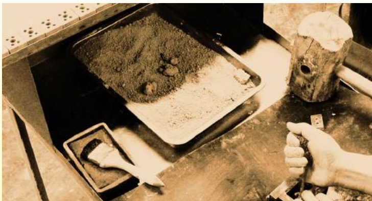
Borniers en porcelaine fabriqués manuellement par pressage au marteau : remplissage manuel du granulats humecté (Collection privée)
